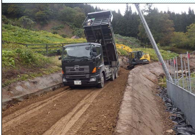
工事用道路へ改良土(路床材)投入
