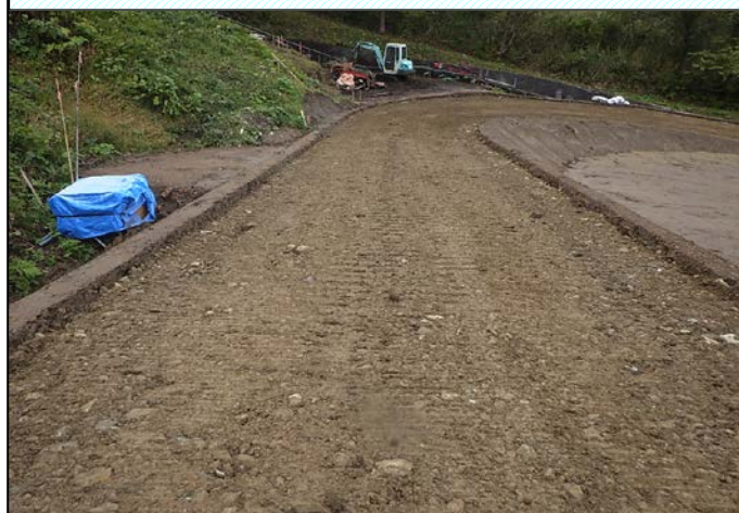
工事用道路(路床部)完成
