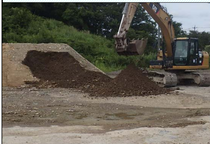
発生土の一次分級 ( \phi 150mm)
