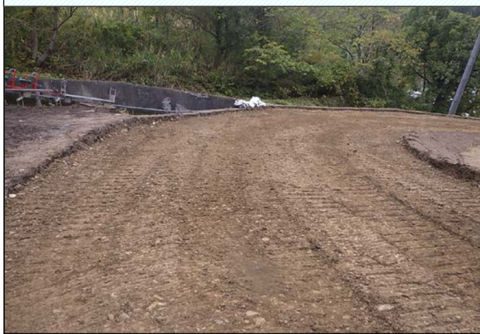
工事用道路(路床部)完成
