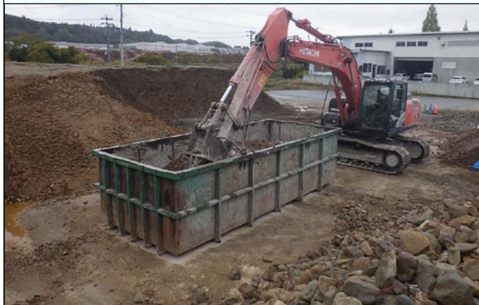
一次分級後 \phi 150mm アンダーは生石灰改良し路床土利用へ
