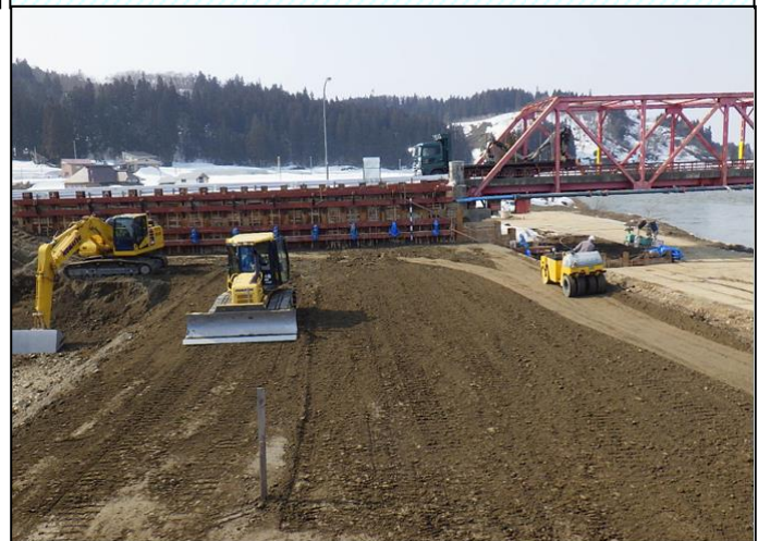
築堤盛土 施工状況
