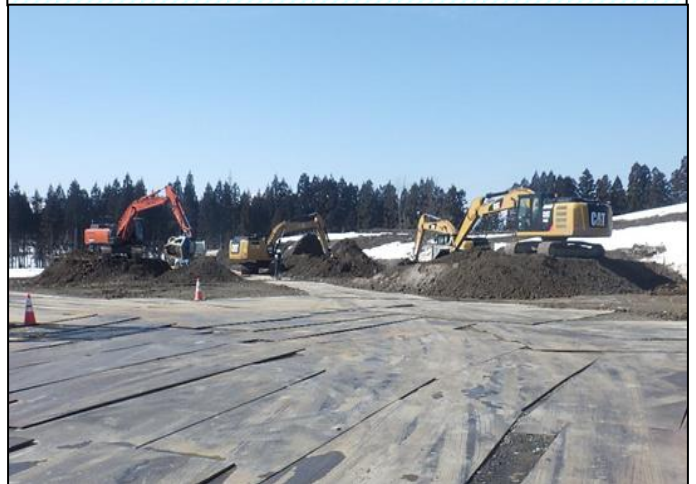
固化材による改質状況(安定処理)
